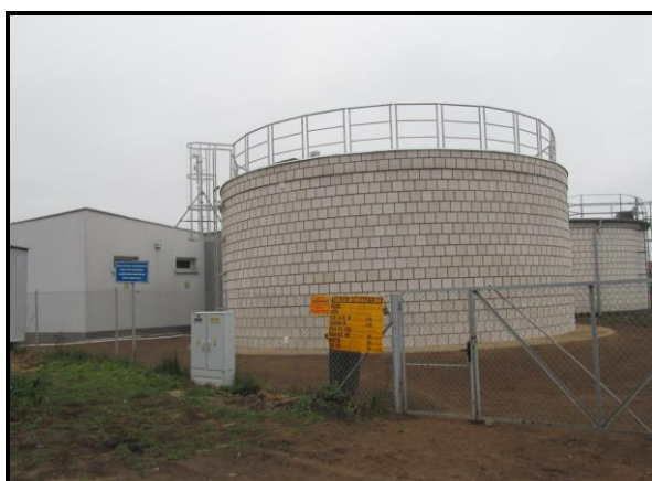
Teren ochrony bezpośredniej Ujęcie wody poziomej
