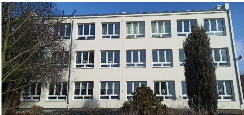
Fot. Termomodernizacja budynku Szkoły Podstawowej w Roszkowie
