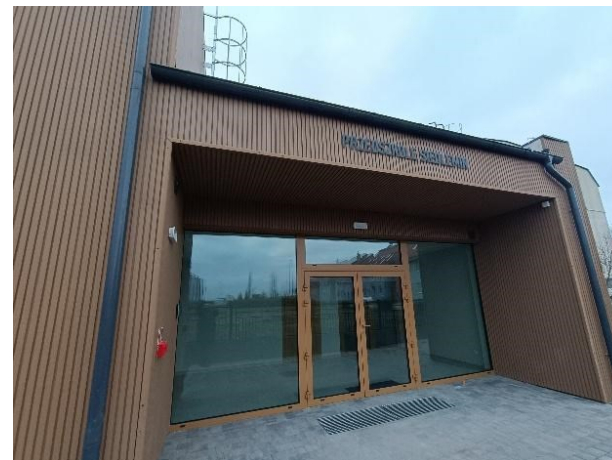
Fot. Budowa przedszkola i sali gimnastycznej w Siedleminie
