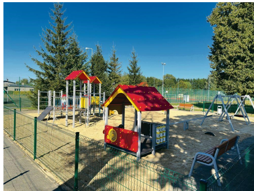
Fot. Budowa placu zabaw przy ul. Wrocławskiej w Jarocinie
