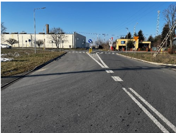
Fot. Budowa drogi dojazdowej do terenów inwestycyjnych przy "Węźle Jarocin"
