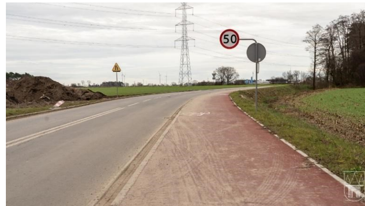
Fot. Budowa drogi do terenów inwestycyjnych w miejscowości Golina
