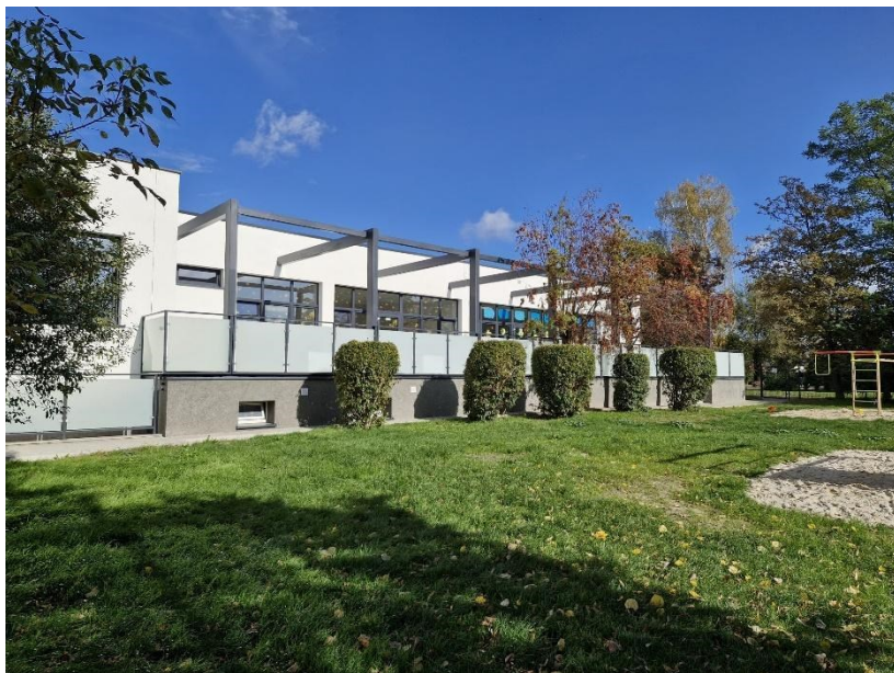
Fot. Rozbudowa i przebudowa Przedszkola Publicznego w Mieszkowie i utworzenie oddziału żłobkowego
